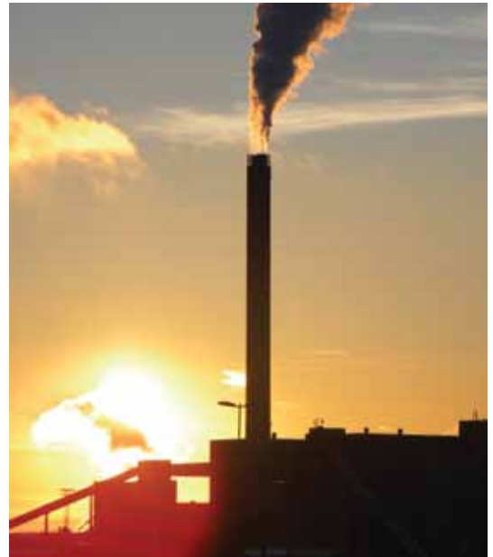
Une centrale de cogénération à Helsinki en Finlande.
